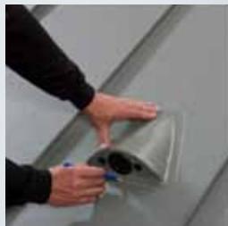
Positionieren der Solarluke
