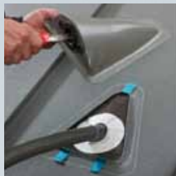
Wellrohrdurchführung gekreuzt einschneiden
