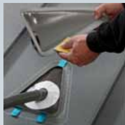
Klebeflächen anschleifen (siehe Anleitung am PREFA Spezialkleber)
