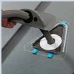
PREFA Spezialkleber auf- tragen und PREFA Solarluke aufsetzen
