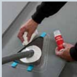
Klebeflächen reinigen
