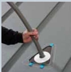
Rohrmanschette aufkleben und Wellrohr durchführen
