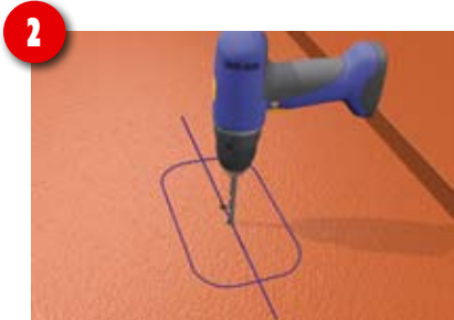
Langloch in der Prefalzbahn vorbohren
