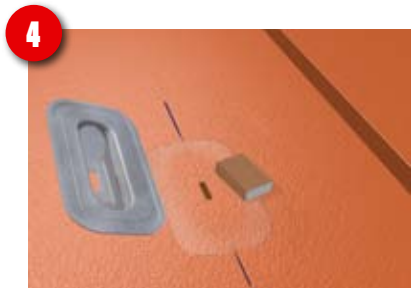
Klebestelle an der Prefalzbahn anschleifen.
