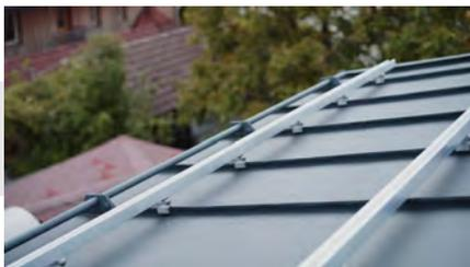
Im ersten Schritt wird das Schienensystem für die Montage der Solarmodule fertiggestellt.
